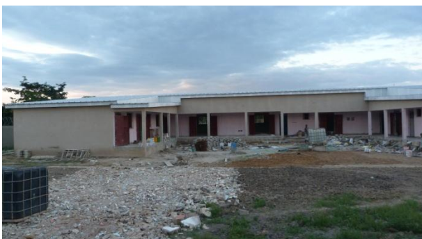
Ecole en construction
