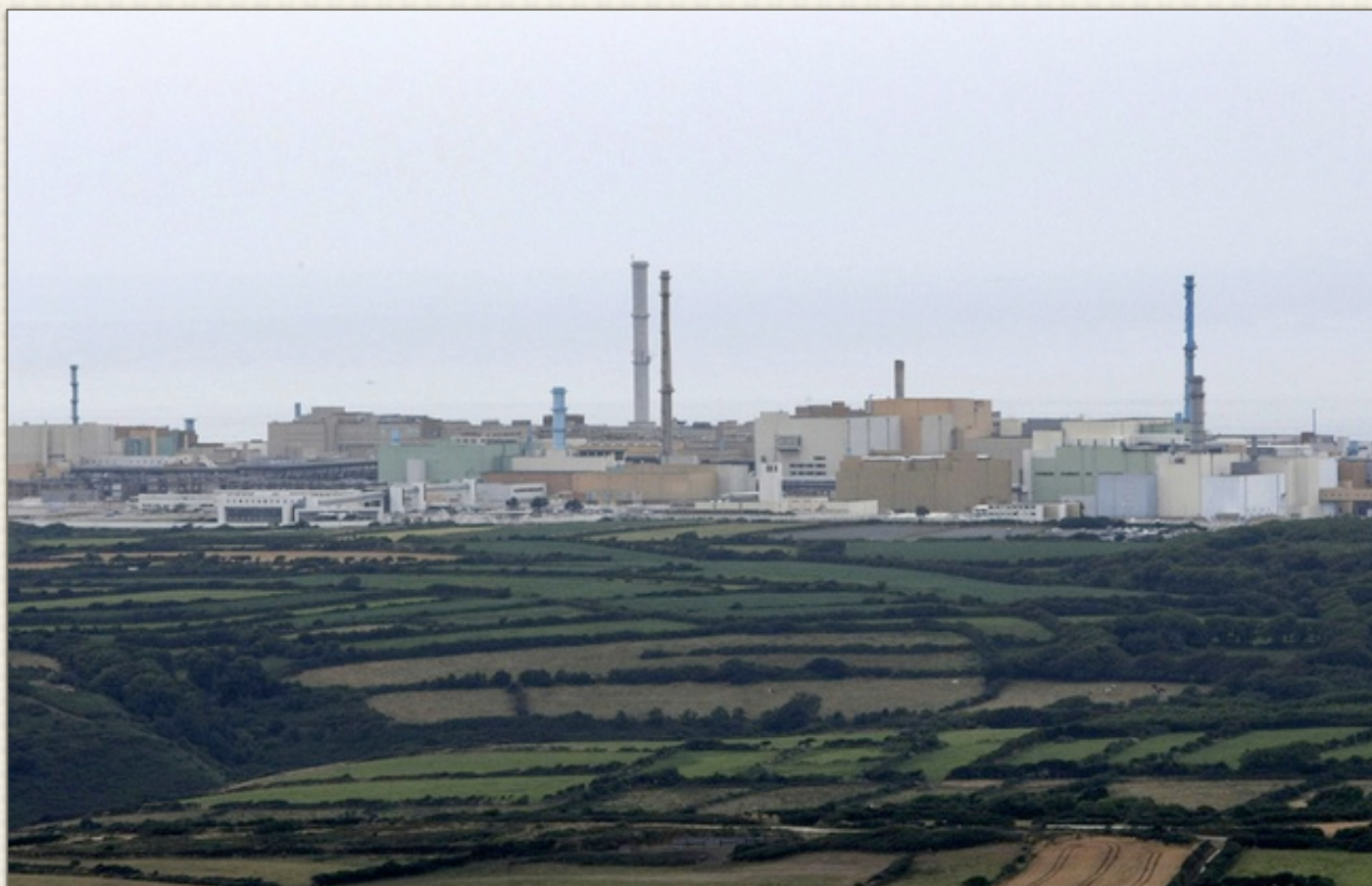
Le Centre de retraitement des déchets nucléaires d'Arèva à La Hague. - TRAVERS ERIC/LE FLOCH/SIPA
