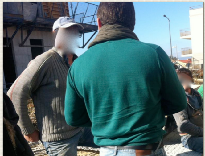
Des ouvriers portugais sur un chantier près de Clermont-Ferrand, fin 2012. © Rachida El Azzouzi
