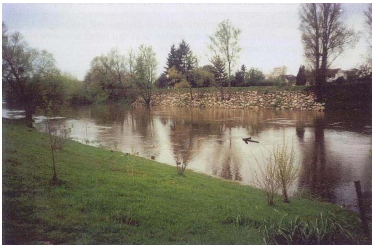
**Levée de terre de l'Abricot en rive droite, localement protégée par des enrochements.**
