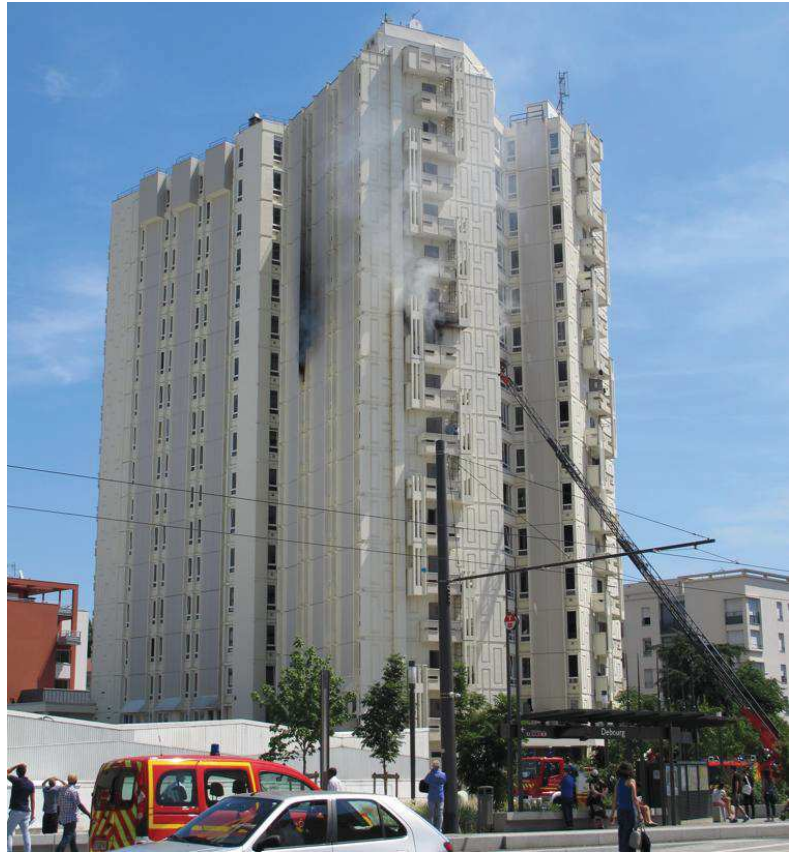
■ Le feu est parti du 9 e étage de l'immeuble et s'est propagé à l'étage supérieur. Photo Élodie Castelli
