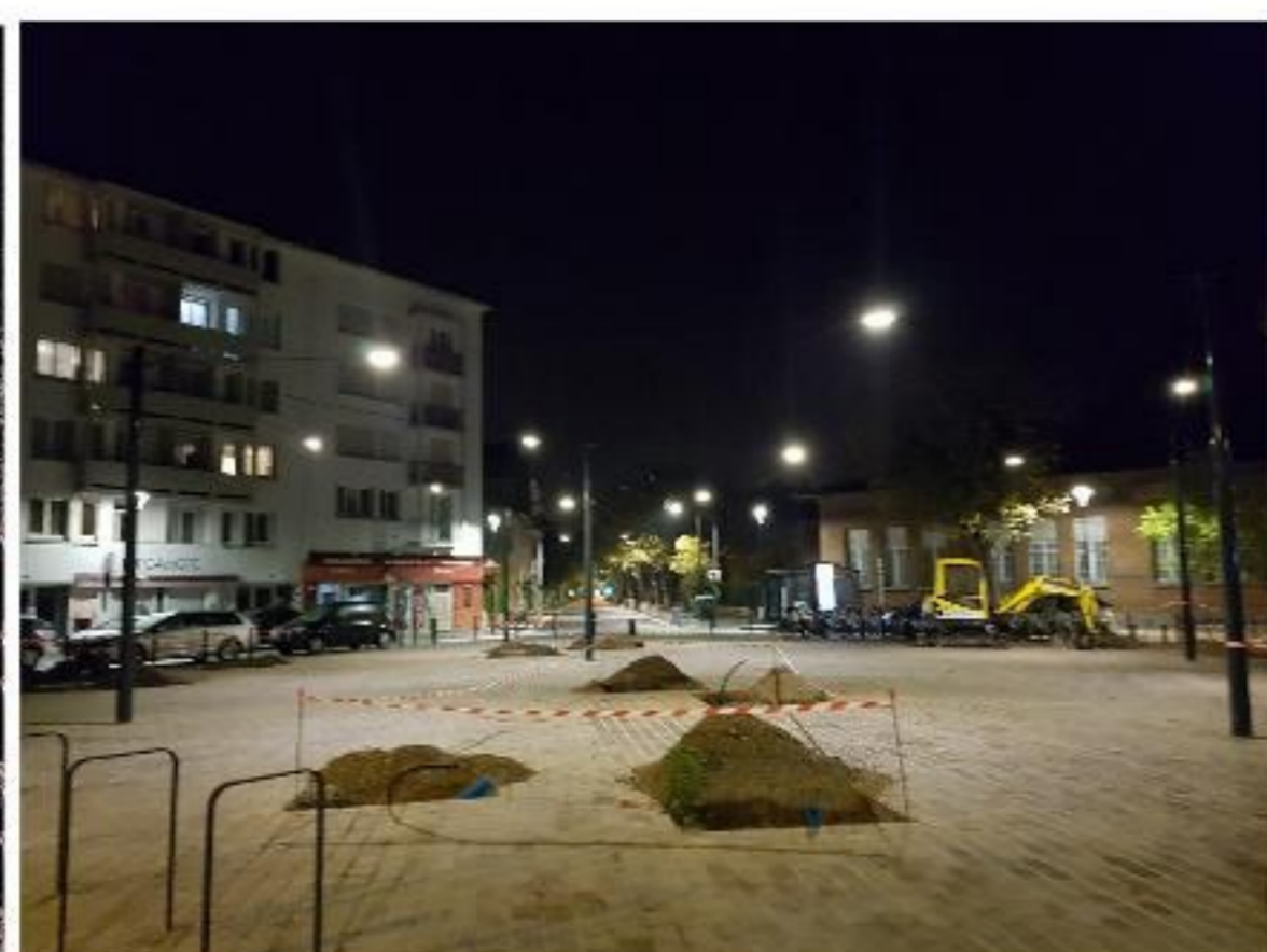
13 novembre éclairage central de la place terminé
