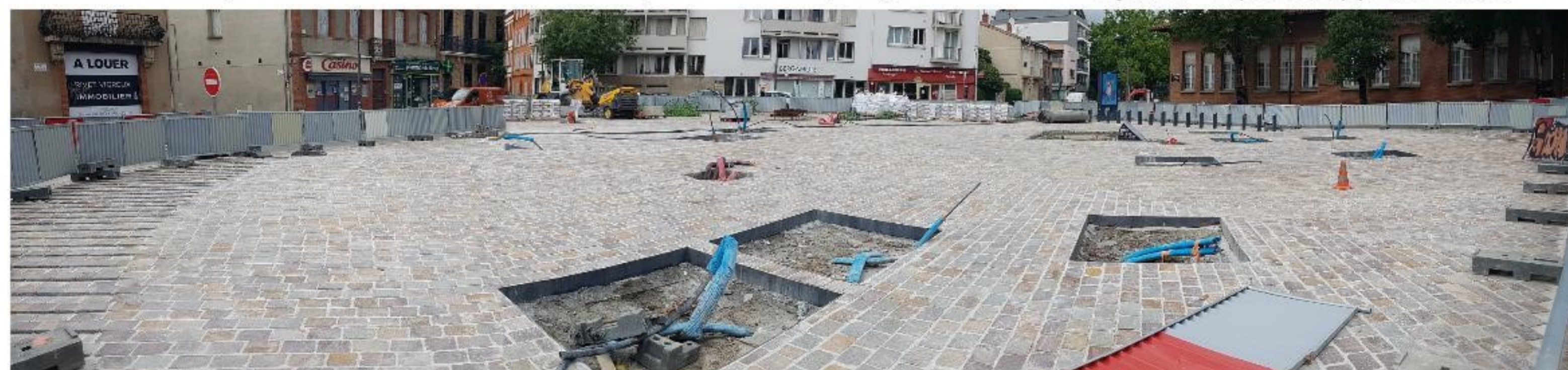
13 aout - le pavage est terminé
