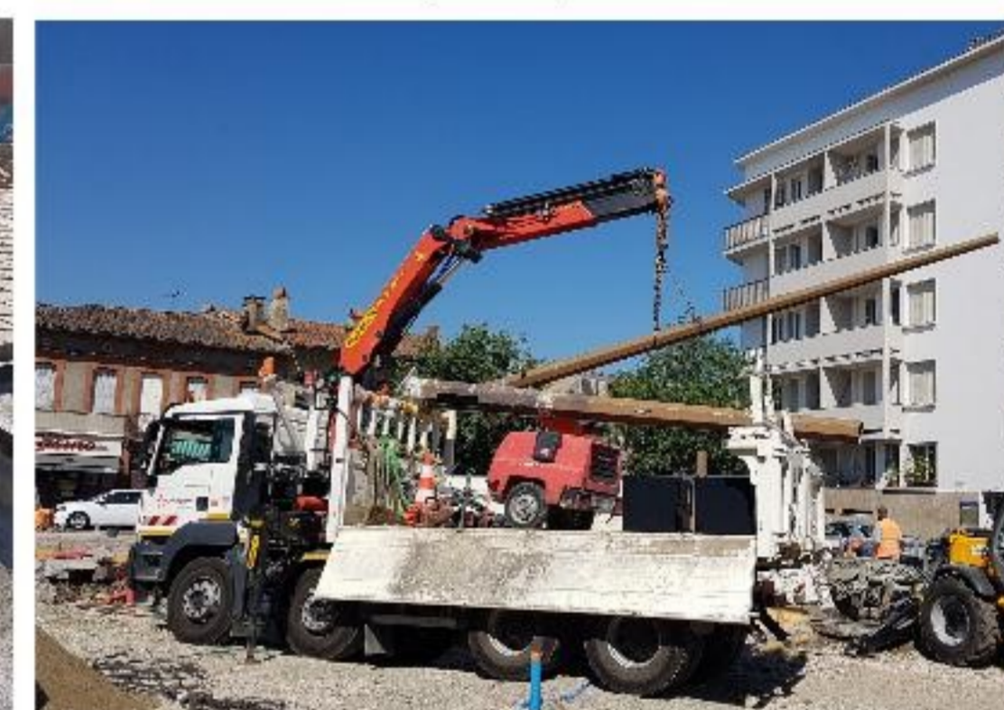
3 juillet - dépose du pylone central
