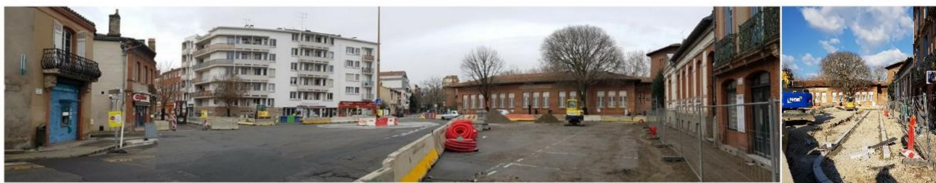
28 janvier 2018 - mise en place du chantier sans stationnement pour les commerces vite corrigé à notre demande
