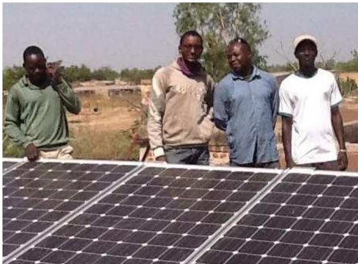
Panneaux solaires sur le toit d'un des bâtiments du jardin pédagogique de Kassou. Derrière posent Gilbert, gardien de Kassou, Amadou Diallo, ingénieur en énergie solaire, Gha, responsable jardin de JdM BF et l'assistant de A. Diallo, novembre 2016
