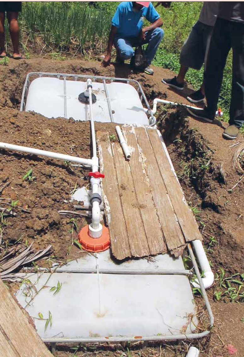
Construction d'un biogesteur par la coopérative agricole de Belle Vue, de Sainte-Lucie, qui utilise des déchets animaux pour produire du compost et de l'engrais liquide.
