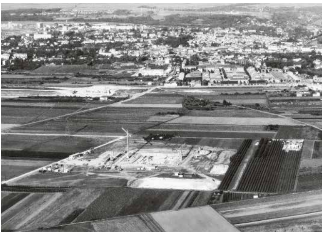
Les fondations de la nouvelle préfecture du Val-d'Oise (Henry Bernard, architecte), circa 1968. © DR
