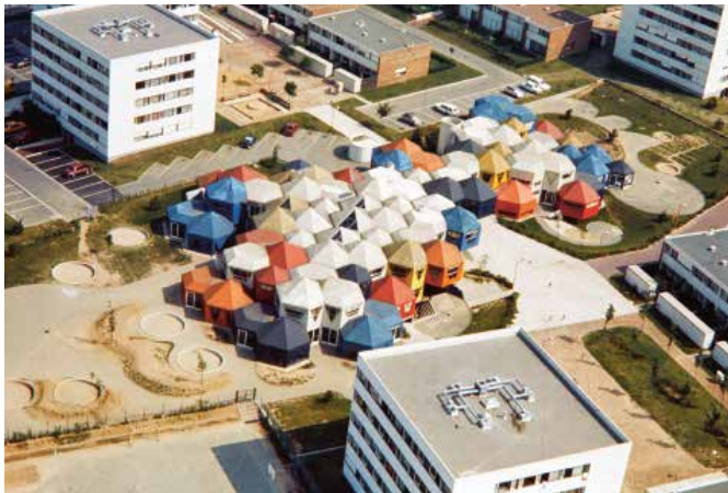
Vue aérienne du groupe scolaire des Plantes en 1975, Jean Renaudie, architecte. © DR, ADVO 1532W743
