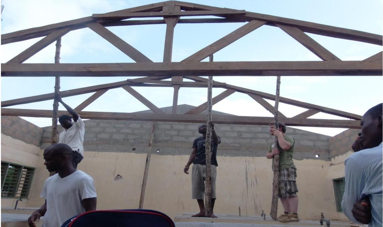
**Repose de la charpente et des tuiles**
