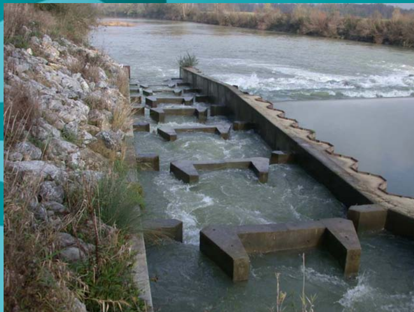
Passes à poissons en génie civil (ex. passe à bassins successifs)
