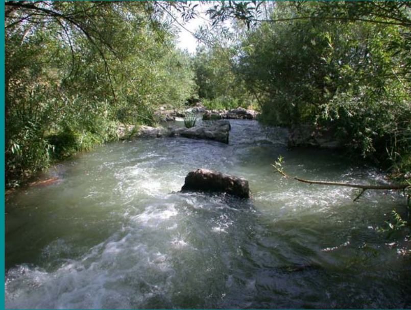
Une rivière de contournement sur le Rhône servant également comme parcours d'eaux vives
