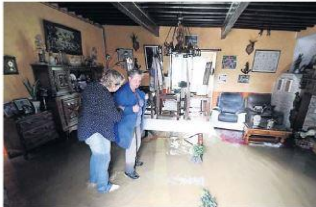
L'eau a envahi le salon de la famille Basse, à l'extrémité sud de la commune. / Photo Laurent Dant.
