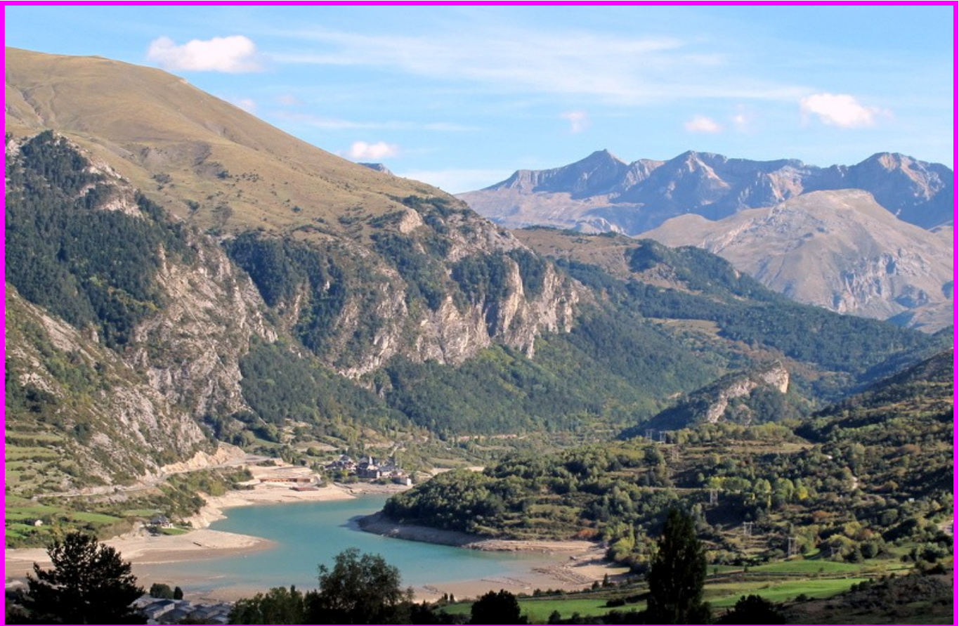
Barrage de Lanuza
