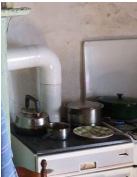
Cuisinière bois et charbon, le conduit de fumée s'encastre dans le coffre en bois qui entoure le foyer de la cheminée Le foyer de la cheminée restait accessible, le coffre en bois avait deux portes sur l'avant
