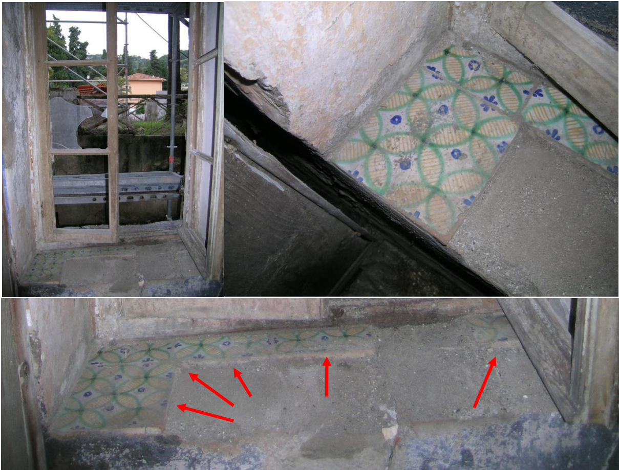
Carreaux émaillés présents sur l'appui d'une fenêtre de la maison ancienne (photos 2010).
