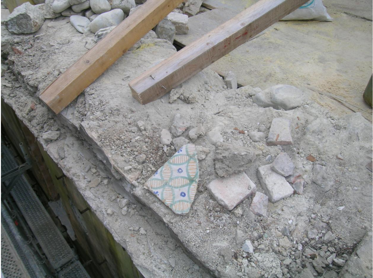
Janvier 2011 : détail de l'arase du sommet du mur de la maison ancienne avec un fragment de carreau émaillé.
