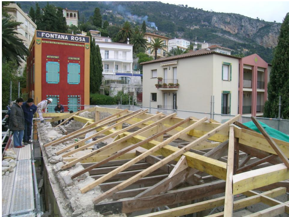
Janvier 2011 : arase du sommet du mur de la maison ancienne contenant des fragments de carreaux émaillés réemployés mis au jour à l'occasion des travaux de restauration.
