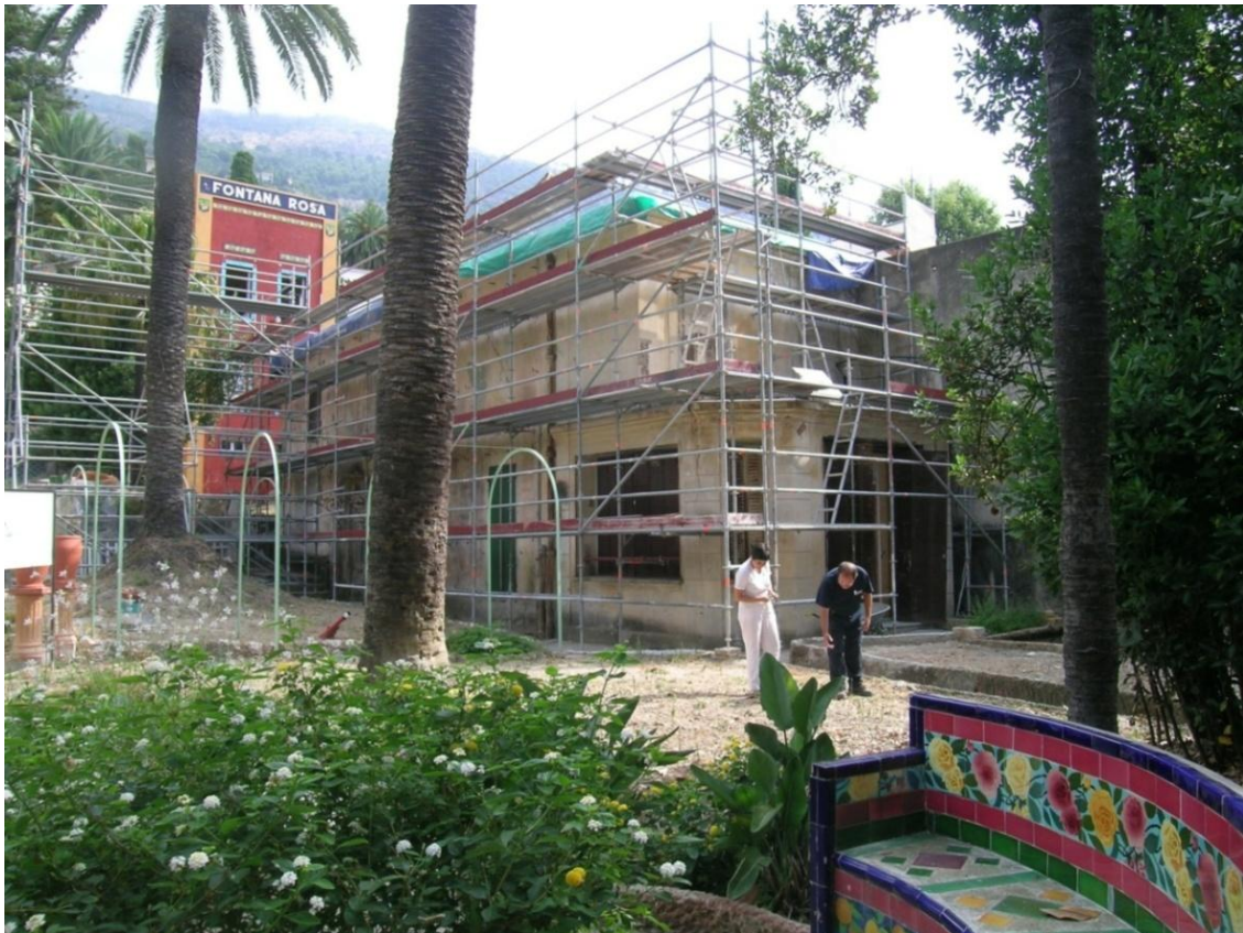
Lieu de découverte du carreau émaillé avec mortier, indiqué par Alain Bertin du service des jardins de la Ville de Menton, près d'une maison ancienne en cours de restauration.
