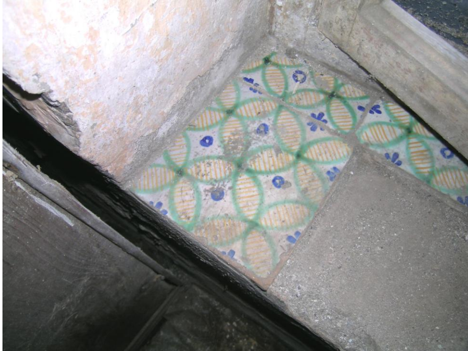
Janvier 2011 : carreaux émaillés, réemployés pour l'ornement de l'appui d'une fenêtre du rez-de-chaussée de la maison ancienne, mis au jour à l'occasion des travaux de restauration.
