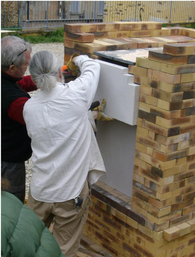
2 - Mettre la 1<sup>ère</sup> porte du four en briques perforées et numérotées, puis les plaques de Siporex (fragiles) puis terminer par la deuxième couche de briques numérotées
