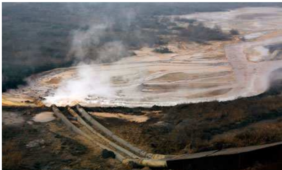
Photo 3 : ci-dessus, l'entreposage peu orthodoxe des résidus des
