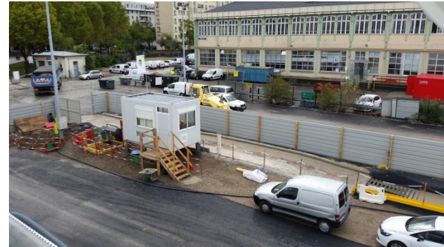
4. Débourbeur/décrotteur-aire de lavage camions avant sortie du site en activité depuis lundi 21/09/2015
