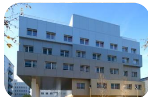
Rue de Mantes, Colombes (92) EHPAD
