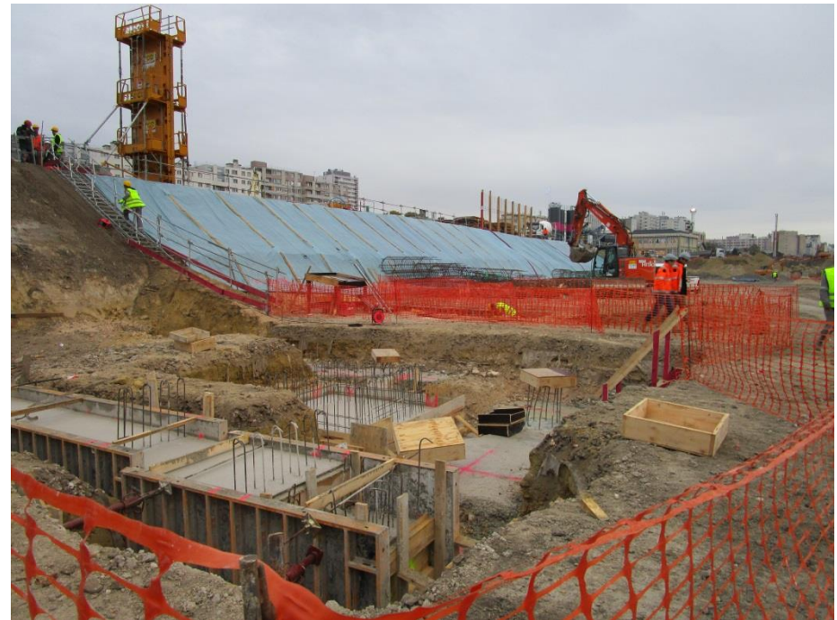
8'. Fondations en fond de fouille en cours
