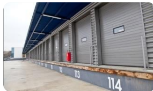
Zac de Montjoy, Bonneuil-en-France (95) Plate-forme de messagerie
