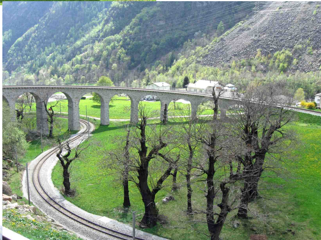
D'autres vues du passage sur, et sous, le viaduc de Brusio
