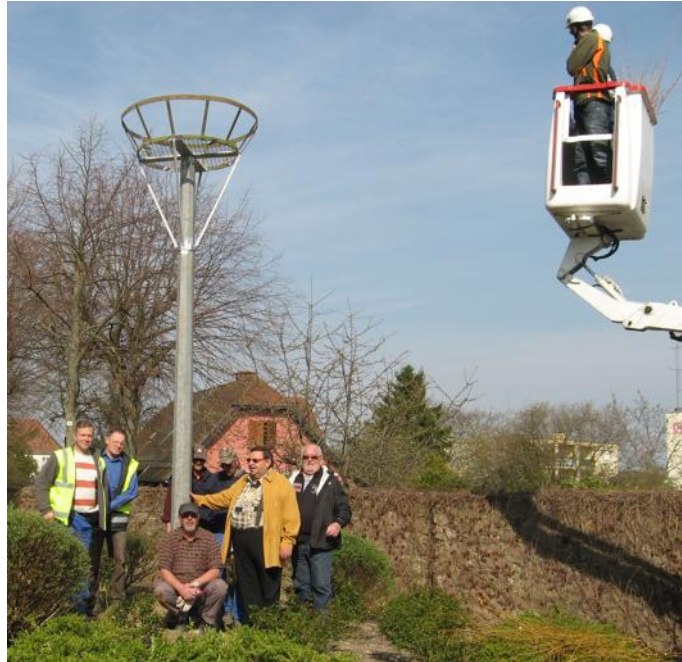
Installation d'un nid de cigogne Promenade de la Citadelle
