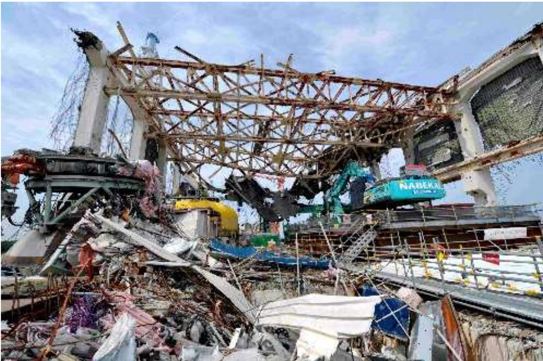
Vue du cinquième étage. L'objet arrondi de couleur jaune est la partie supérieure de l'enceinte sécurisée du réacteur. Le plafond a été soufflé par l'explosion. L'endroit recouvert de blanc, à droite de la photo, est peut-être le réservoir d'immersion des barres de combustible, sous laquelle se trouvent 1535 éléments d'un poids de 460 tonnes.
