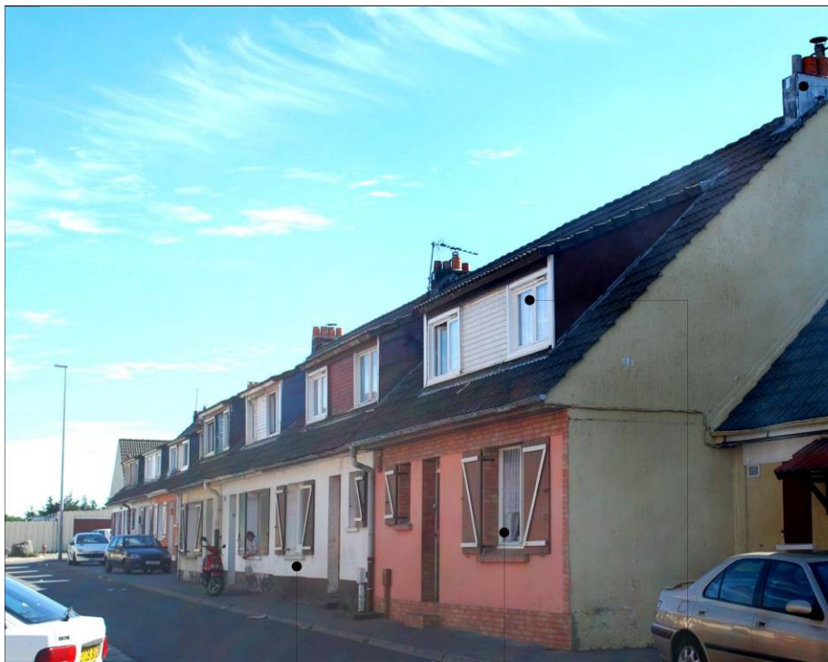
Souche de cheminée maçonnée
