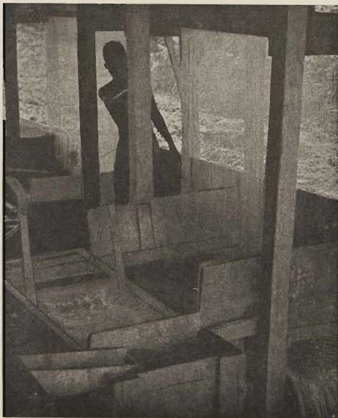
TRAITEMENT DU GRAPHITE - TAMIS A PLUIE
