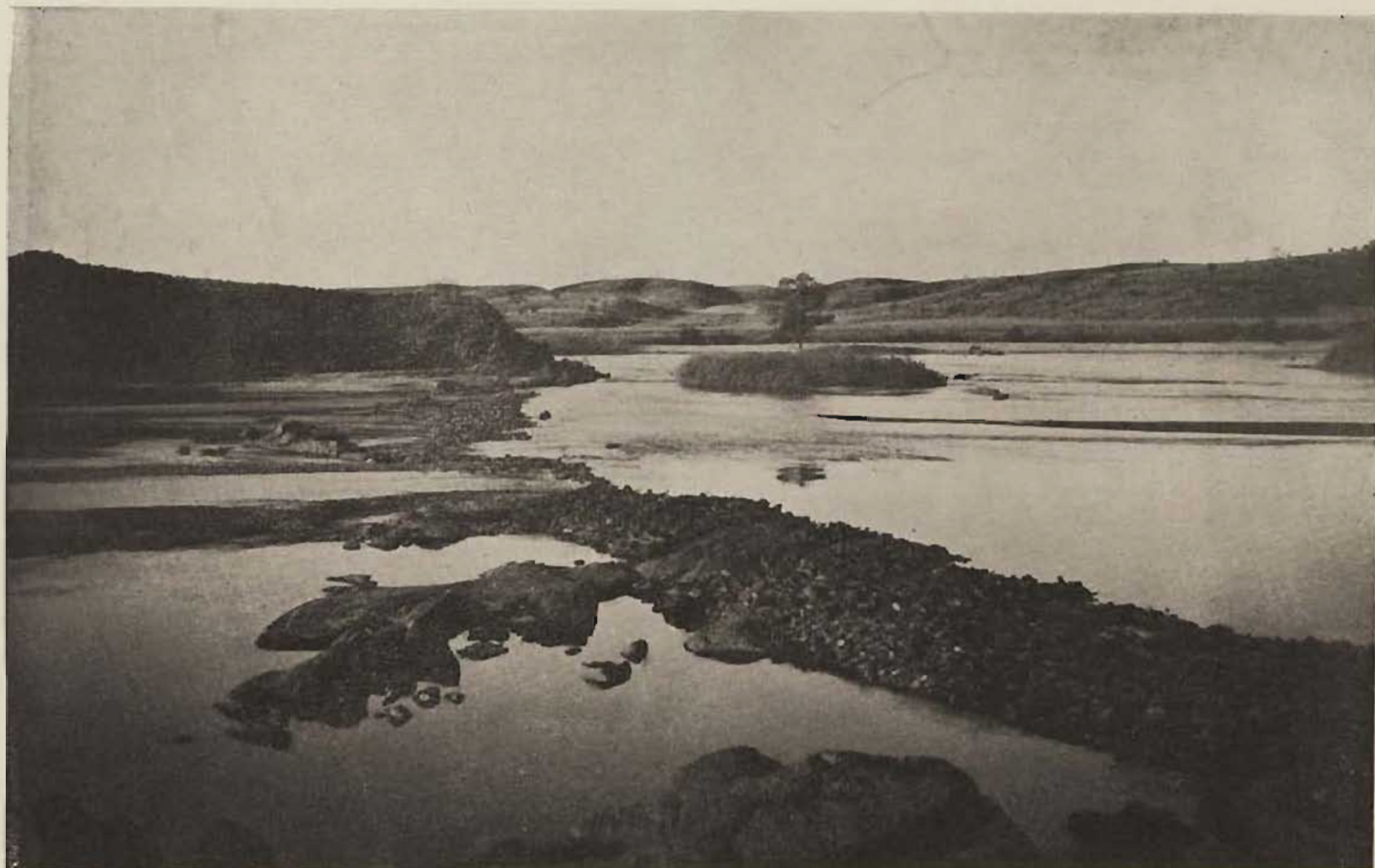
L'OR : EXPLOITATION PAR LA C ie FRANCO-MALGACHE D'ENTREPRISES. BARRAGES EXECUTES SUR LA RIVIERE IKOPO, PRES DE MAYAETANANA
