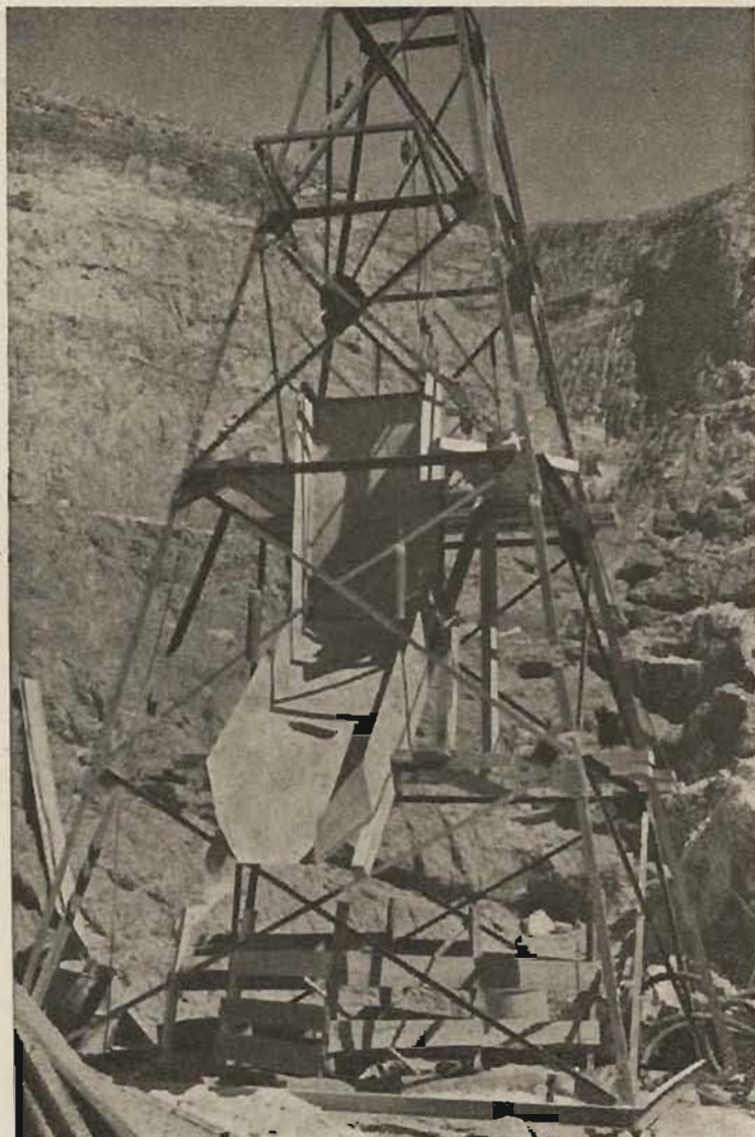
BERYL. - CHANTIER DE BEMASOANDRA : CHEVALEMENT DU PUIIS
