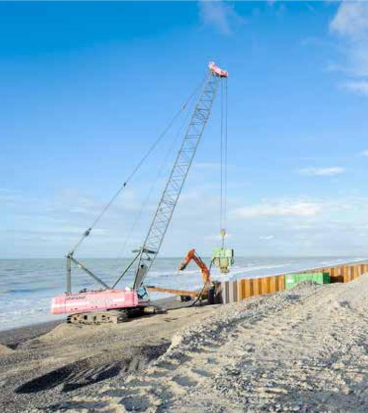
Chantier de construction des épis face à l'érosion côtière à Cayeux sur Mer
