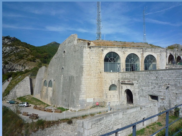
L'entrée du Fort de la Bastille et la salle Lesdiguières
