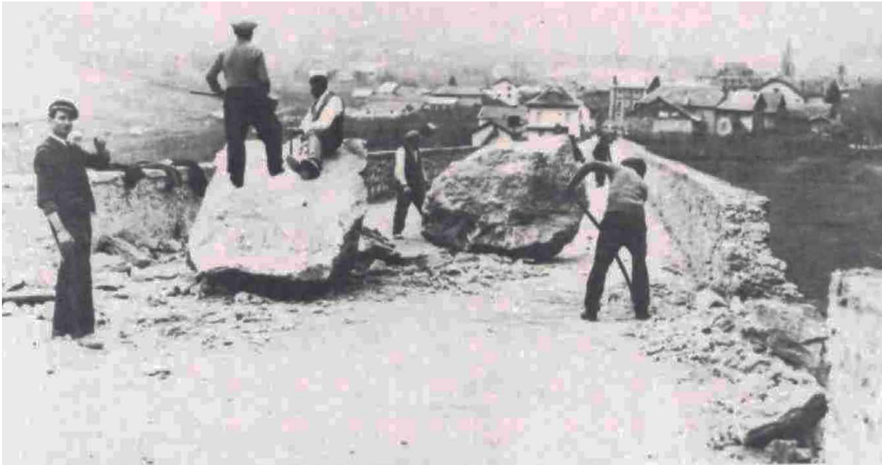
remise en état de la RN90 dans la montée de la chapelle
