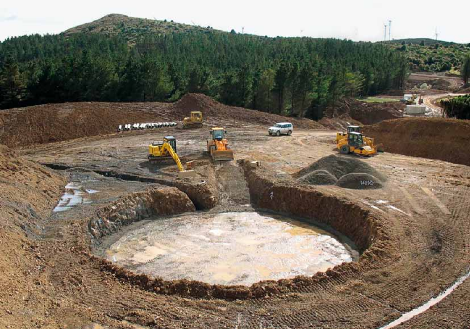
De vastes excavations sont creusées et bétonnées pour ancrer chaque éolienne, Foxton, Nouvelle-Zélande. (photo M. Feyen)
