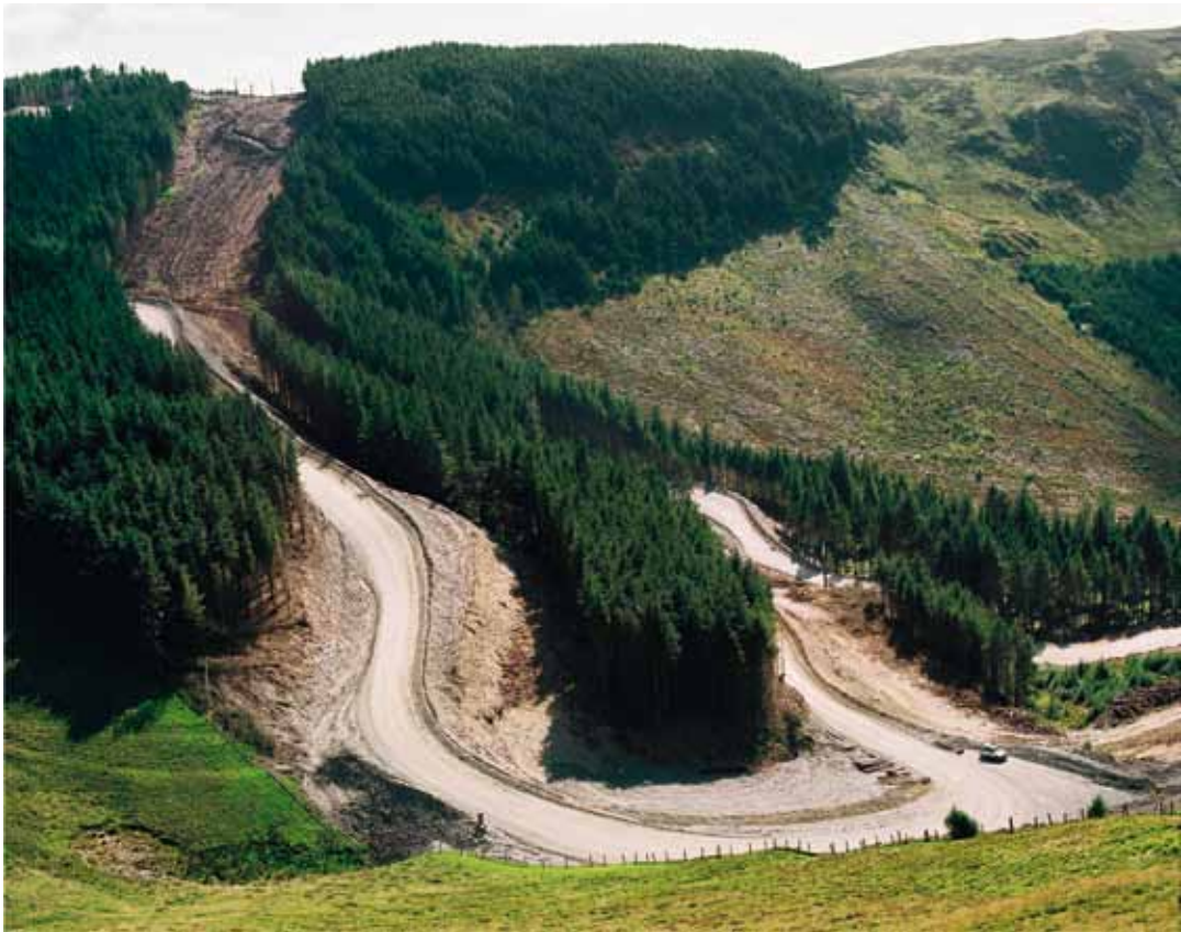
Les coûts de construction en termes d'environnement et de carbone d'une turbine éolienne sont rarement mentionnés. L'enlèvement de la couche de tourbe relâche une énorme quantité de carbone stockée. Une voie d'accès de cinq mètres de large est nécessaire pour desservir chaque turbine. (photo Cefn Croes Action Group)
