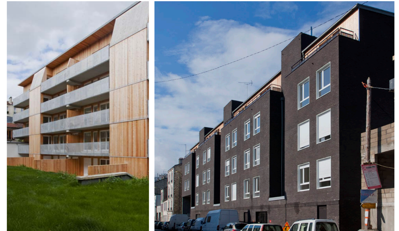
v Logements locatifs social en collectifs sur Rue Mirabeau : système constructif mixte bois-béton.
