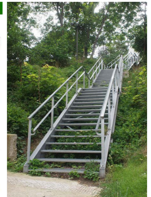
La passerelle de la Cité Louis Bertrand, espace public réalisé par la ville d'Ivry un exemple de cheminement doux à travers un coteau arboré
